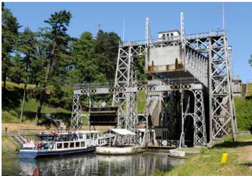
L'ascenseur n° 3 du Canal du Centre. G. Focant © SPW-AWaP
